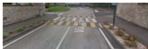
L'attraversamento pedonale rialzato di via Temanza: una buona soluzione
