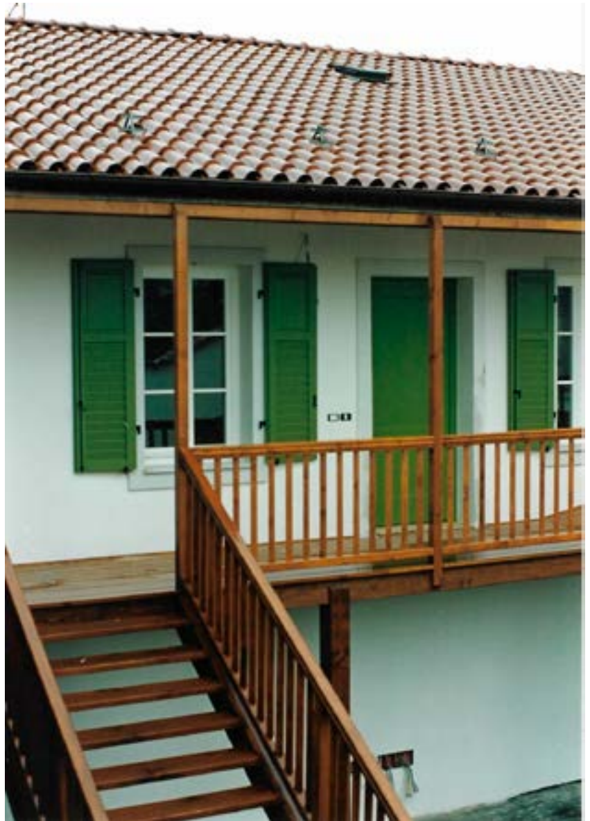
Uno scorcio del palazzo in via San Francesco che il Comune intende mettere in vendita
