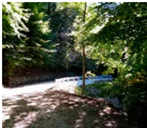
Un tratto della strada dei Vanesi, messa in sicurezza
