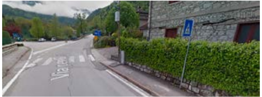
L'attraversamento pedonale "alla Croce": da rivedere
