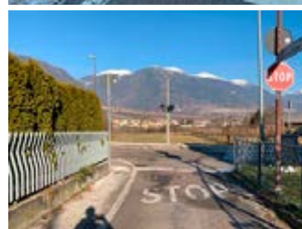
Il punto pericoloso allo sbocco di via Grandi
