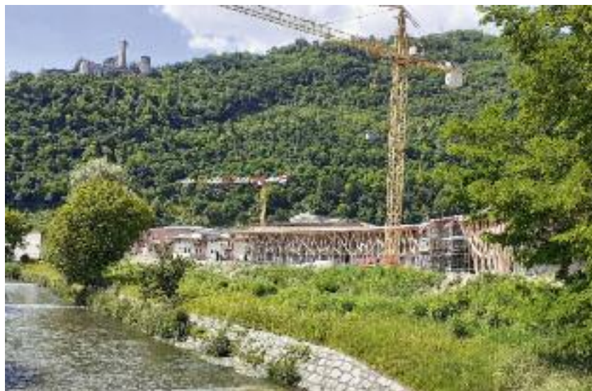
In fase avanzata i lavori di costruzione dello stabile che ospiterà le nuove scuole elementari di Borgo
