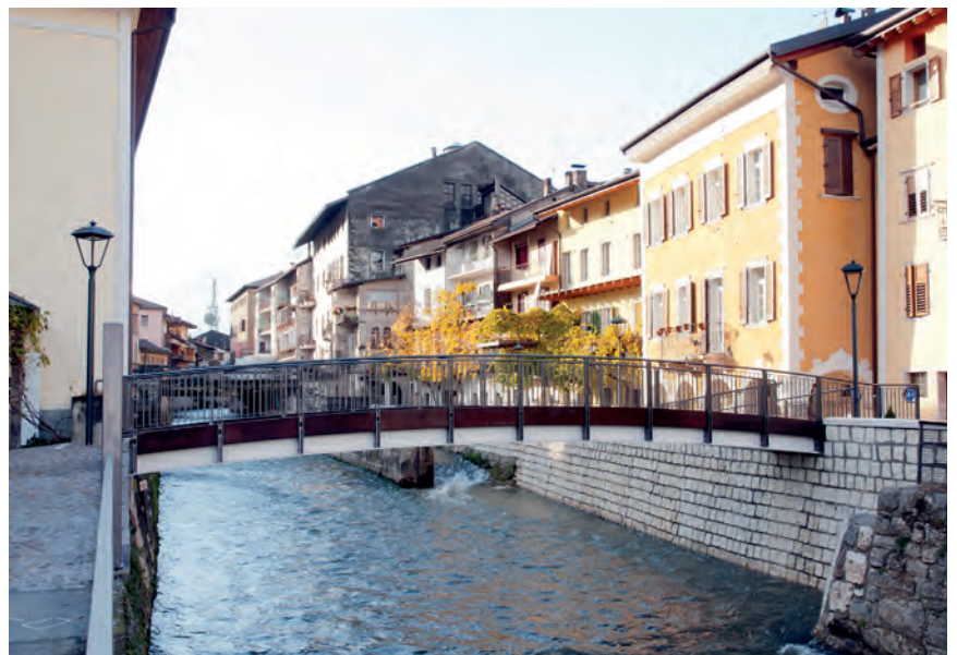
■ La nuova ed elegante passerella che permette di collegare la chiesa arcipretale con i portici del Lungo Brenta
