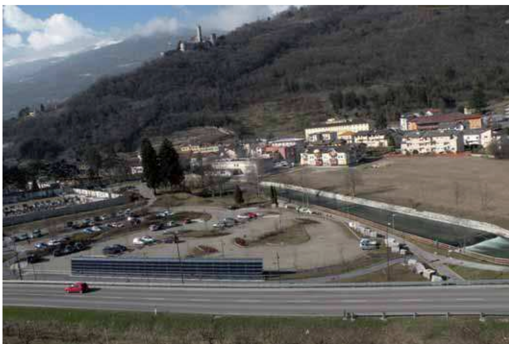
Le barriere installate poco prima della stazione intermodale, viste dall'alto - Foto di Massimo Luzzana
