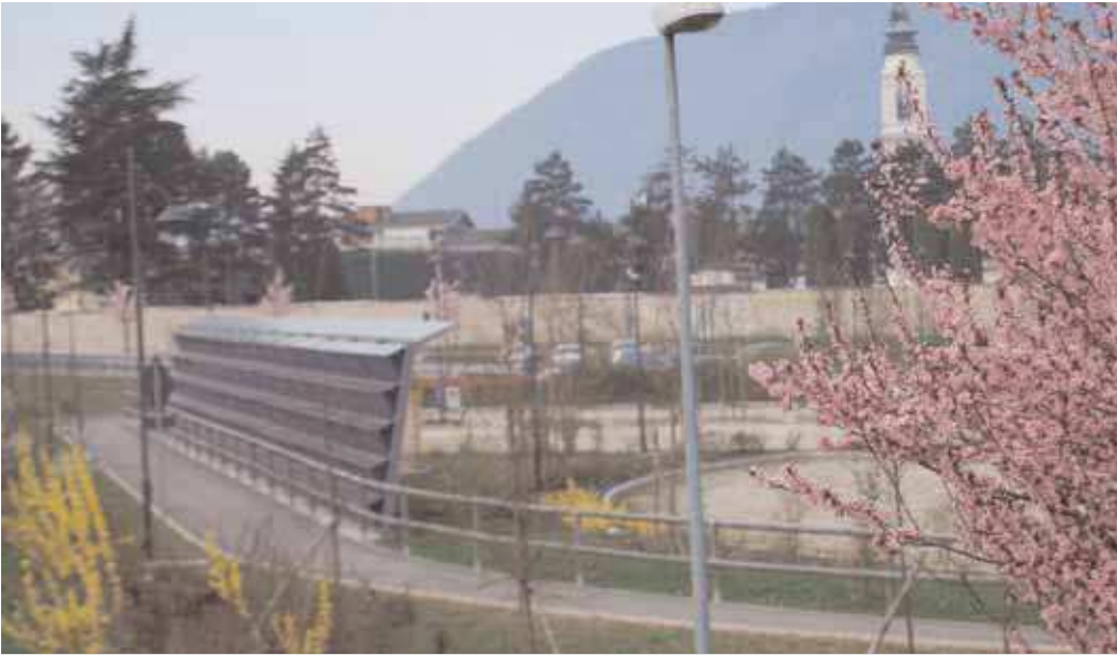
Un totale della barriera antirumore con pannelli fotovoltaici ben integrata anche con la...fioritura primaverile
